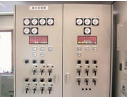
浄化センター
